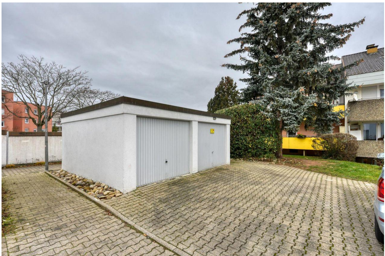
Garagen & Haus Süd
